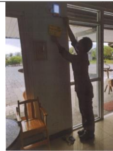
緊急照明燈移位設置照片
