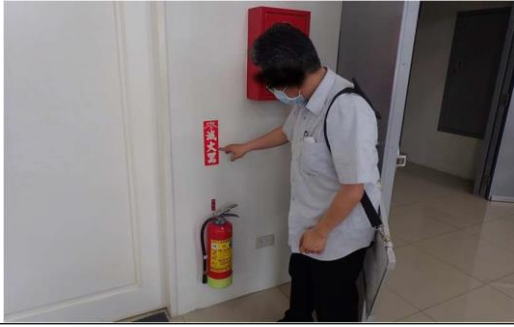
加設滅火器照片
