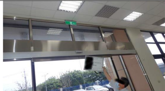
出口標示燈移位設置照片
