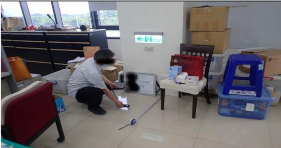
避難方向指示燈移位設置照片
