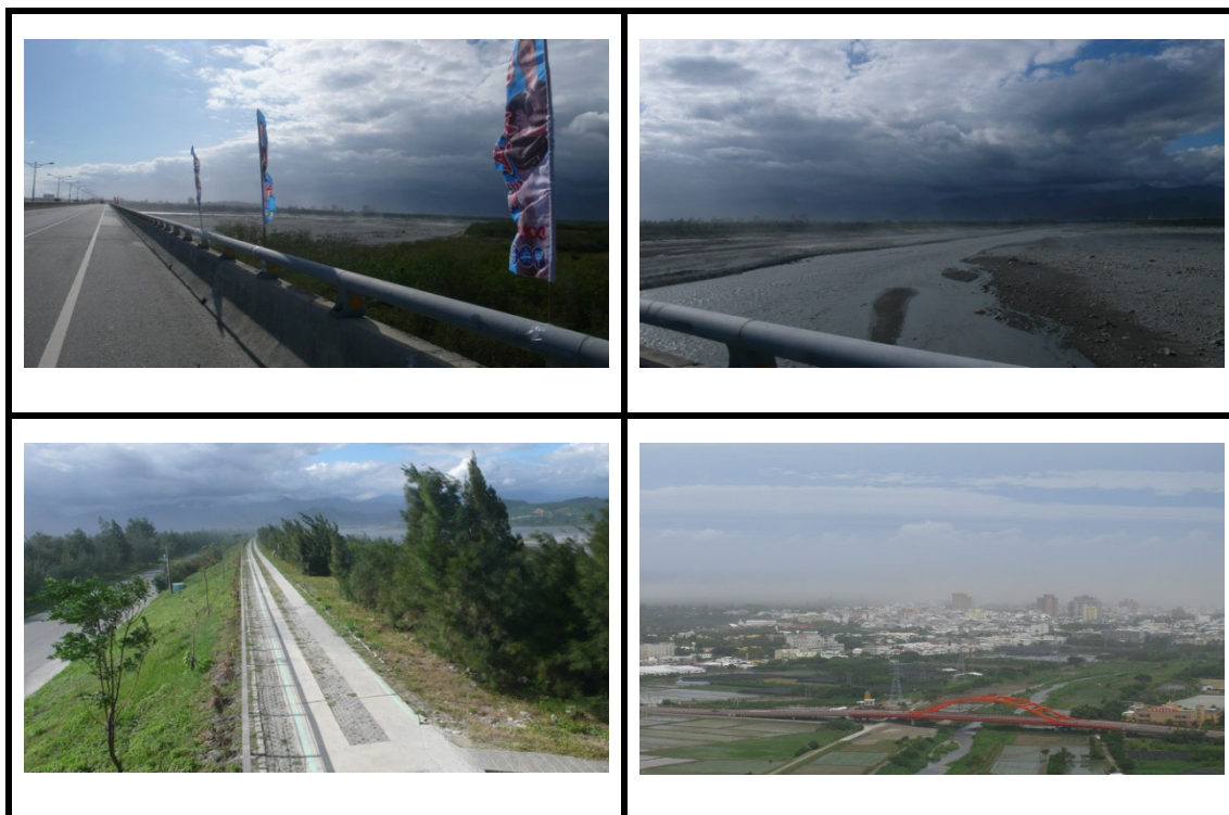
圖 1-23 臺東縣塵暴災害照片
