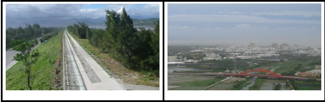
圖 2-18 臺東縣塵暴災害照片
