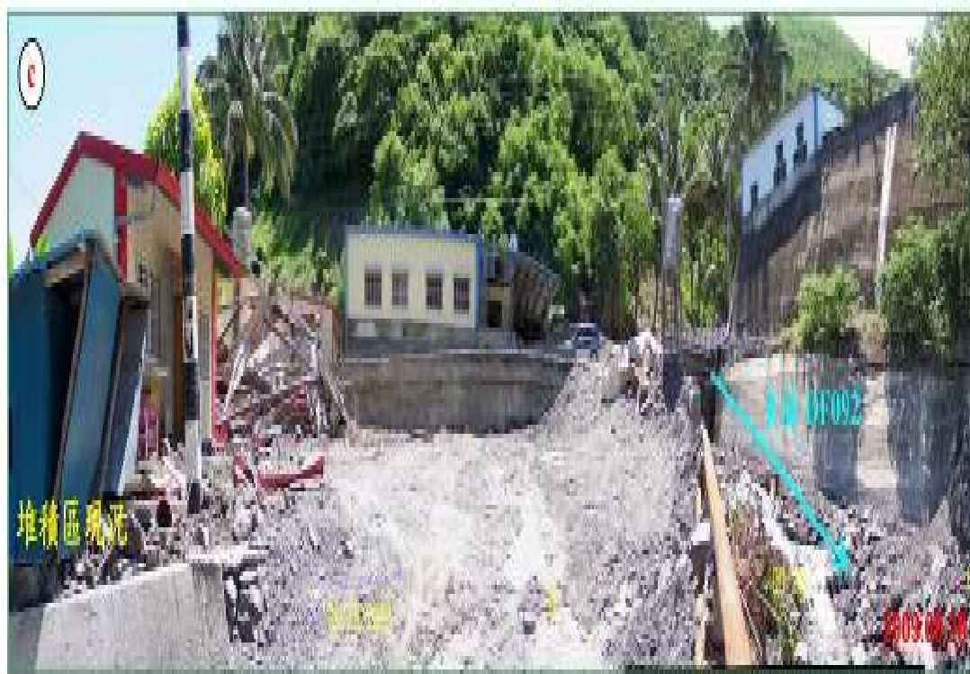
圖 1-3 土石流堆積區現況
